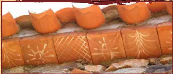
Ces génoises sont décorées au lait de chaux. Il s'agit des tuiles du débord des toits, dont les décors géométriques devaient sans doute protéger du mauvais sort.
